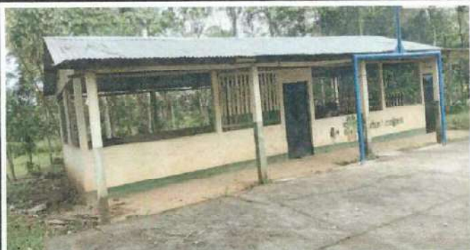
Foto 1: MODULO 2 Vista Panorámica del modulo 1 que se va a Remorzar
