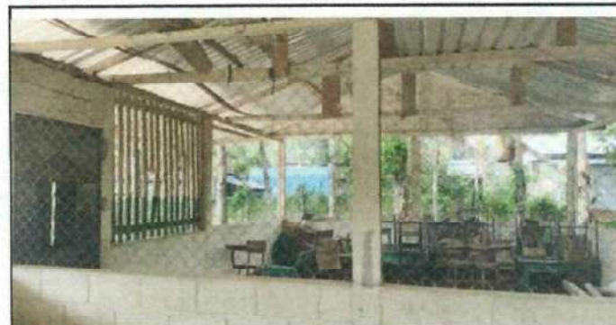
Foto 6: MODULO 2 Cambio de 4 Ventanas mallas por balcones de metal, continuidad más hiladas de Block.
