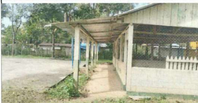
Foto 2: modulo 2 Cambio de laminas por ampieacion de corredor.
