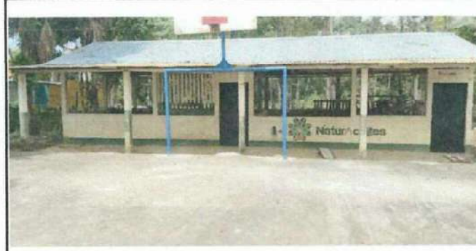
Foto 4: MODULO 2 En esta parte de en frente se va colocar 4 Ventanas de balcones de metal y se va continuar con mas hiladas de block.
