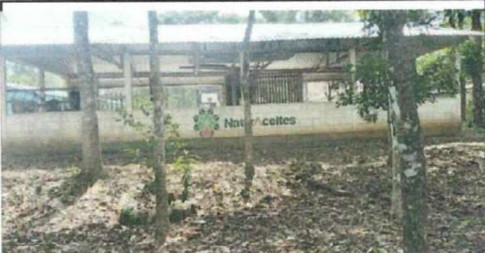
Foto 3: MODULO 2 Sustitucion de 4 ventanas de Balcones de metal y se va continuar con mas hiladas de block.
